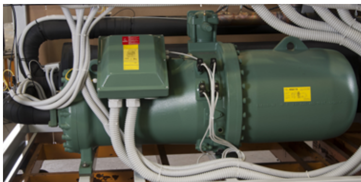
Compressore a vite - Screw compressor
