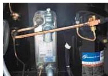
Compressore SCROLL SCROLL Compressor
