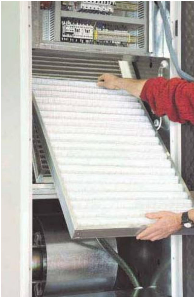
Dettaglio estrazione filtro dell'aria Air filter replacement detail
